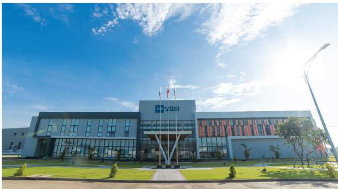
Nhà máy nhôm VSGI
